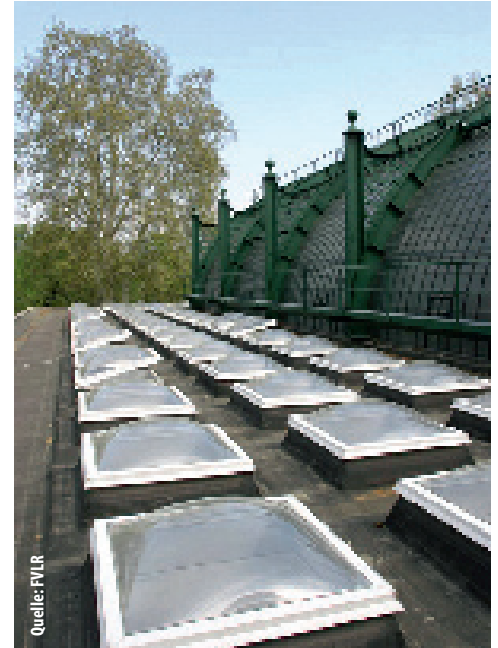
Kleine, gleichmäßig verteilte Oberlichter sorgen für eine gute und gleichmäßige Ausleuchtung größerer Räume.
