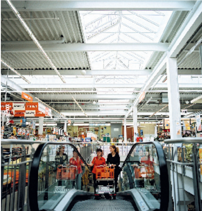
Lichtbänder ermöglichen eine gute und gleichmäßige Versorgung von größeren Räumen mit Tageslicht.
