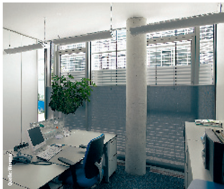
Im Bild rechts sind die vier Elemente: Sonnenschutz, Blendschutz, Lichtlenkung (oberer Lamellenbereich) und die künstliche Beleuchtung zusammen zu sehen.
